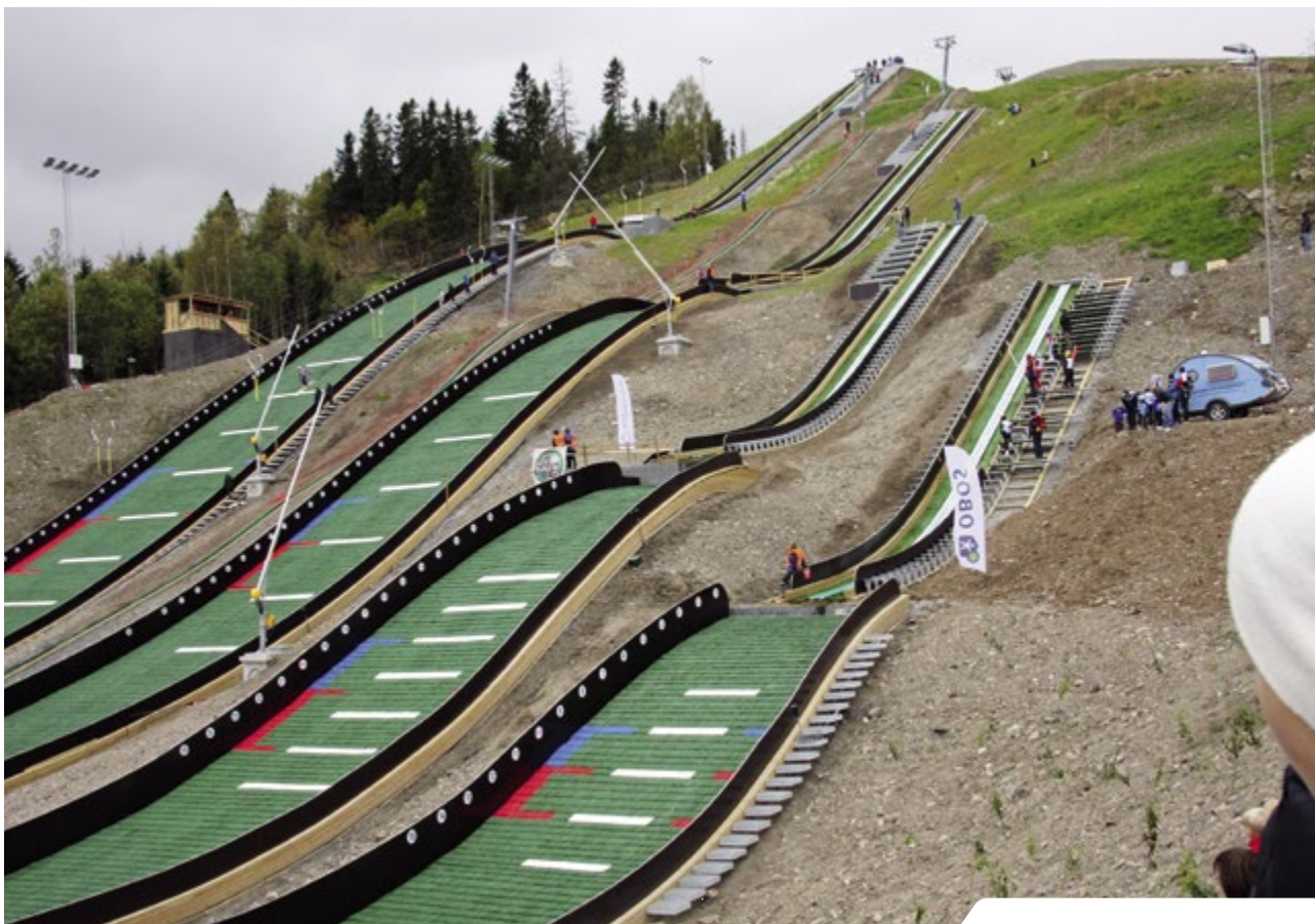
Rekrutteringsanlegget for hopp i Midtstuen. Foto: Ivar Glomstein.
