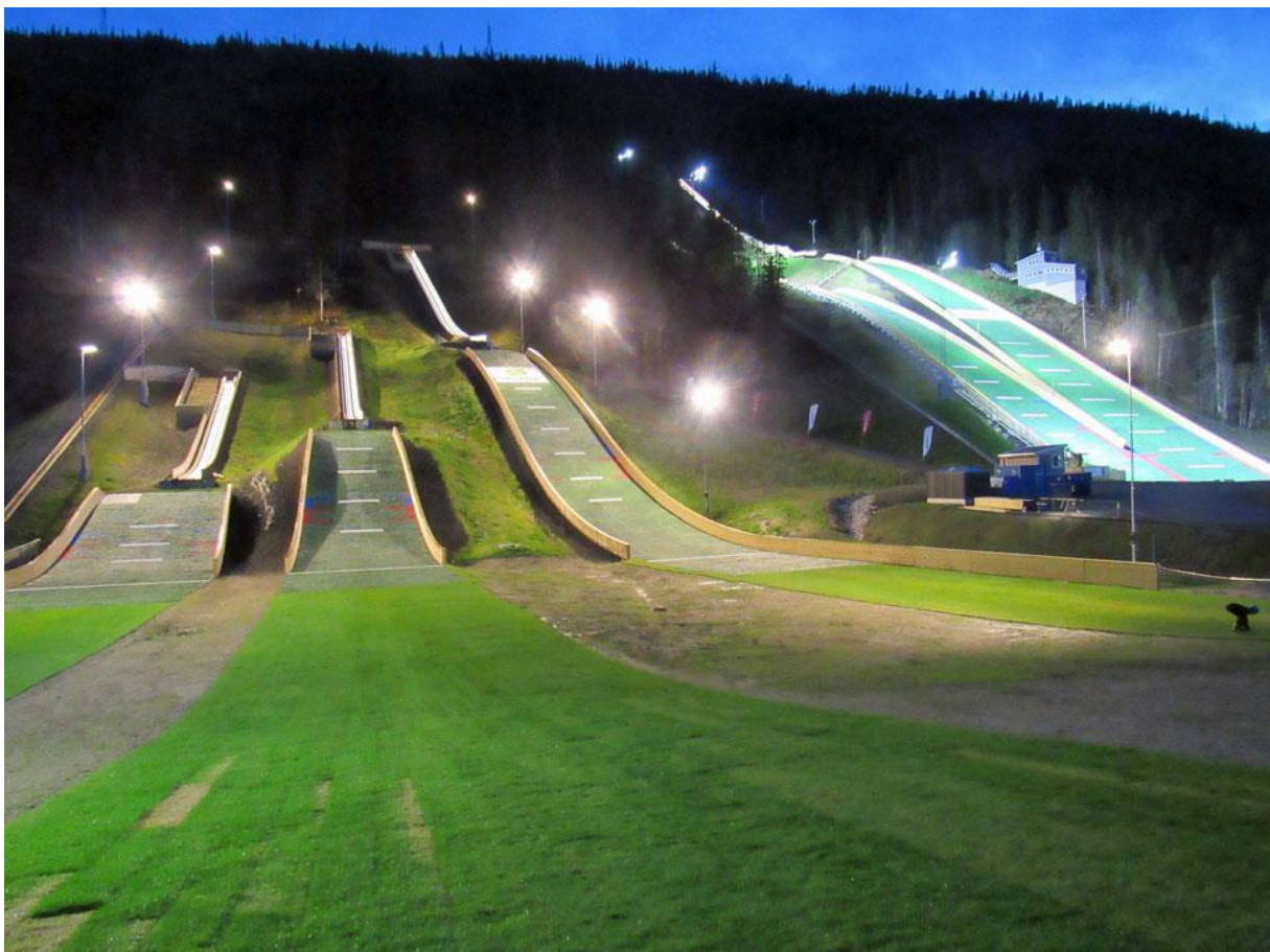
Foto: Fageråsen Hoppanlegg – Mo i Rana
