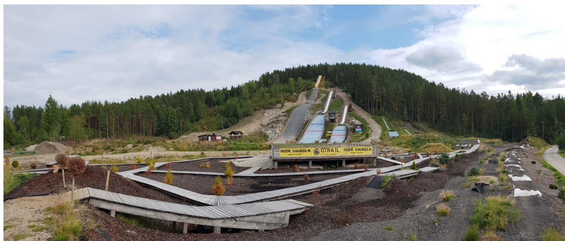
Hoppanlegget på Evje med sykkelløype i forkant
