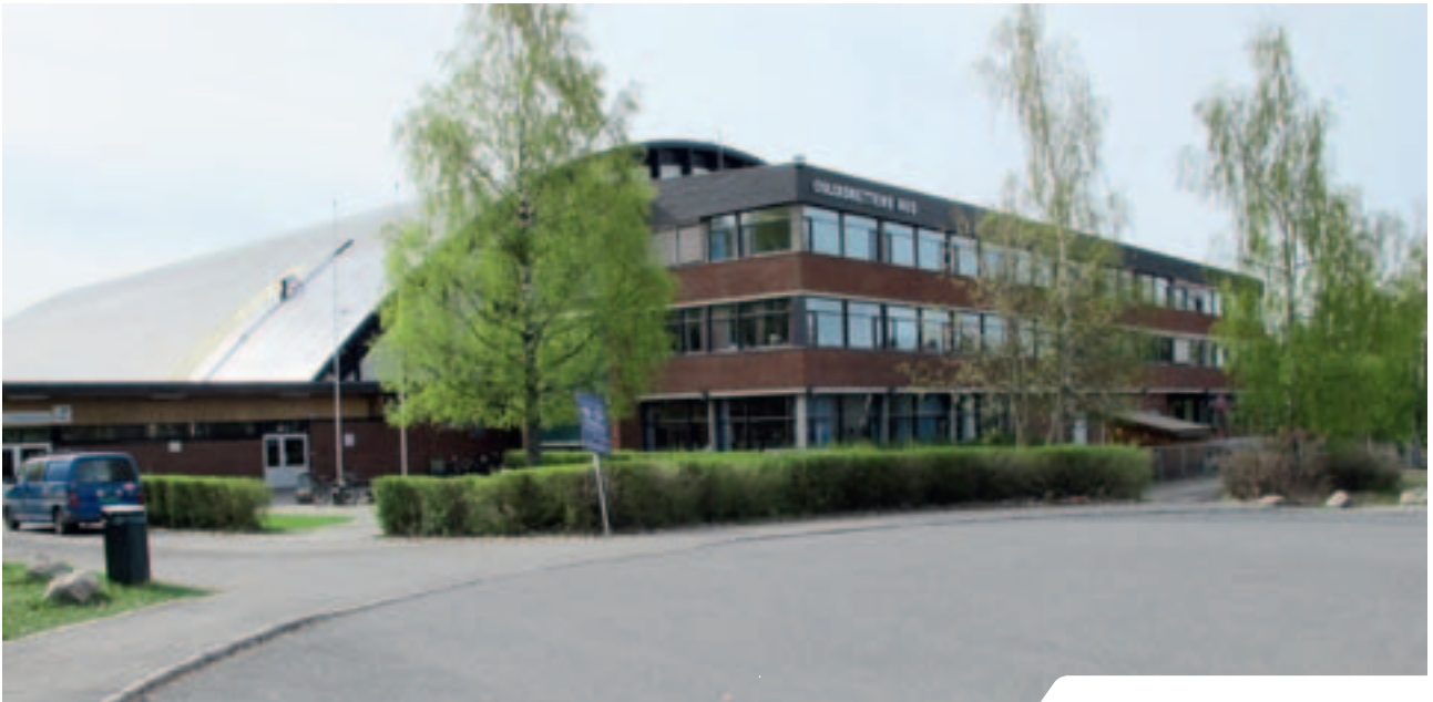
Osloidrettens Hus og Ekeberg Idrettshall. (Foto: OIK)
